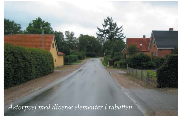
Kig mod Koldingvej ad Åstorpvej
